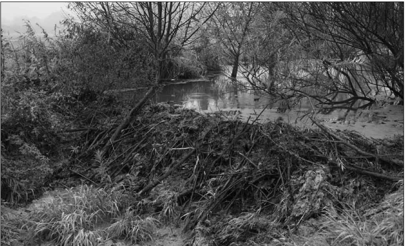
Hráz – 1,5 m vysoká stěna z bahna a propletených větví (bývalá hráz na Pustějovském potoce).
