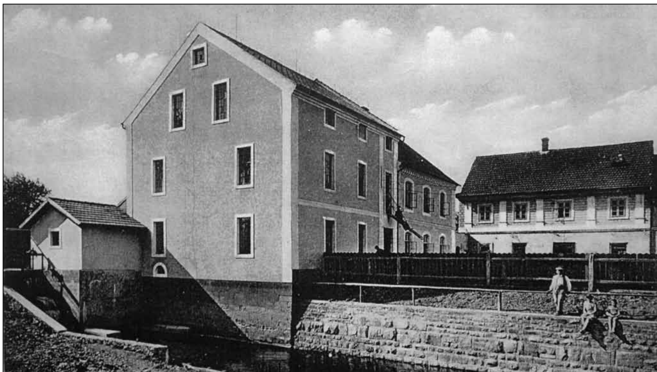
Stav mlýna po požáru (po roce 1933).
