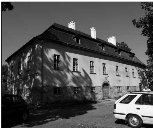
Fasáda zámku před opravou, pohled ze zadní části od parku.
