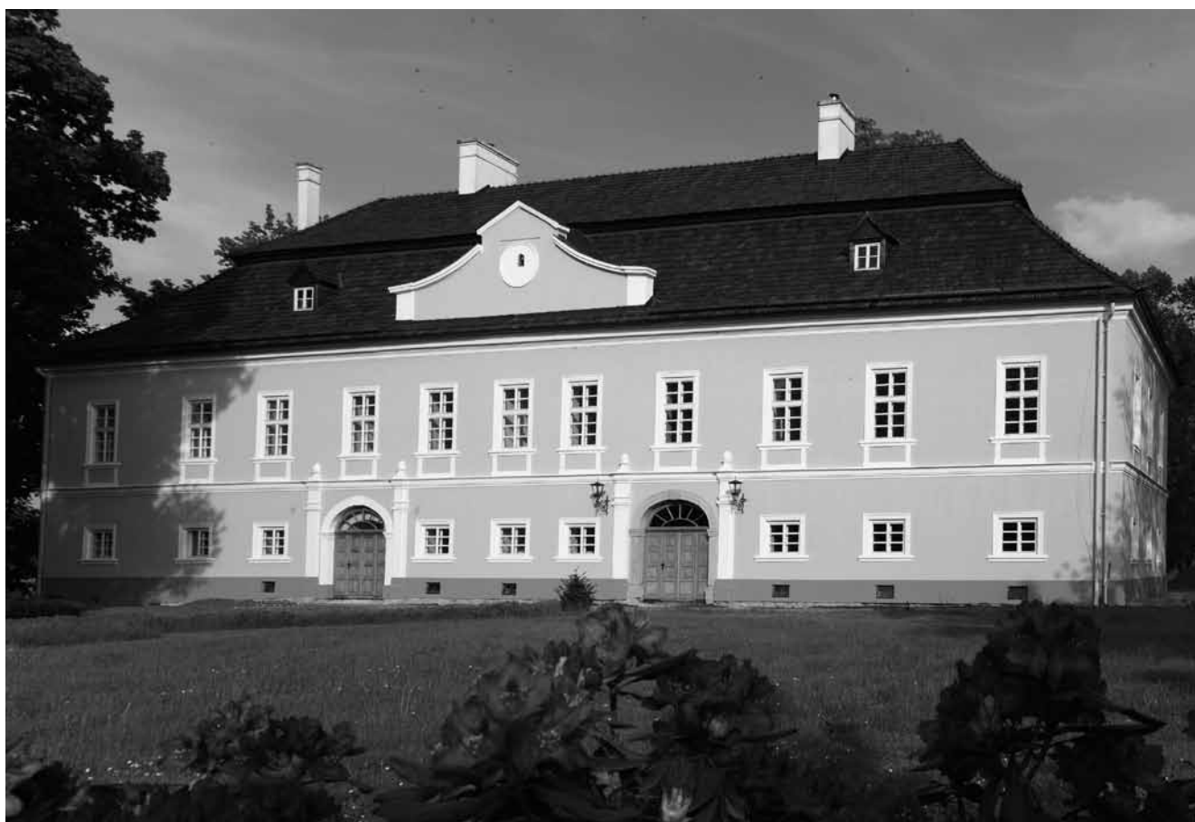
Fasáda zámku po opravě.
