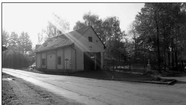
Současná hasičská zbrojnice stojí na místě domu č. p. 198, kde se stalo neštěstí. Kříž vpravo s událostí nijak nesouvisí (Foto Nela Trnčáková).
