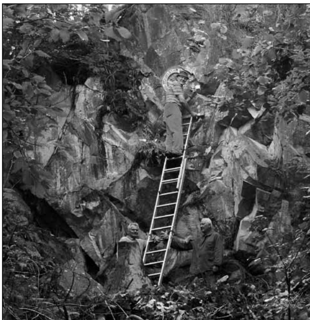
Z prací na opravě znaku (Foto Jaroslav Javora).
