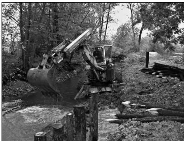
Oprava náhonu dubovými kůly.
